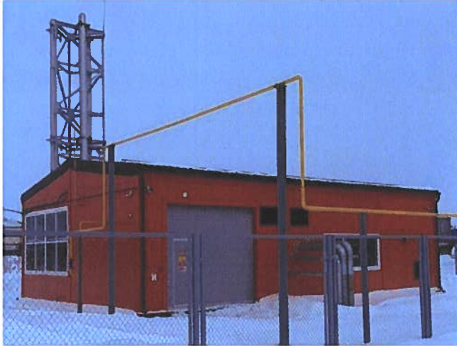
Общий вид здания котельной
