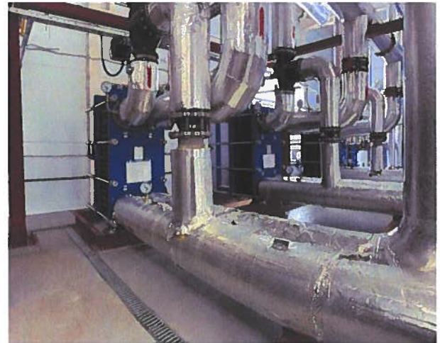
Отдельно стоящая котельная. Общий вид здания и блок теплообменников
