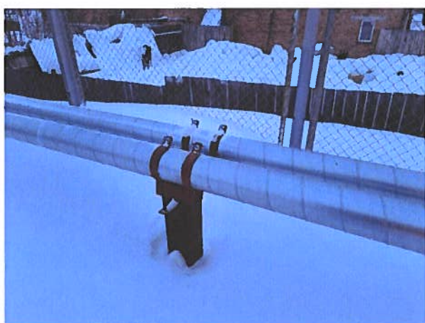
Участок смонтированных тепловых сетей
