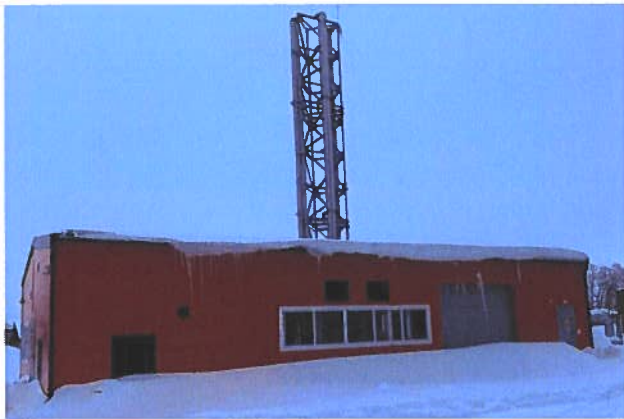
Общий вид здания котельной
