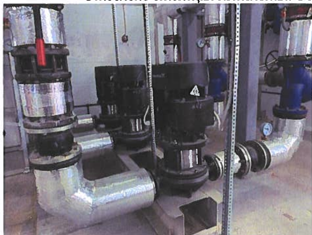
Блок сетевых насосов и запорная арматура
