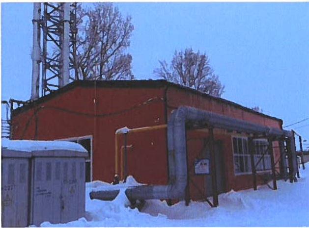
Общий вид здания котельной и основного оборудования
