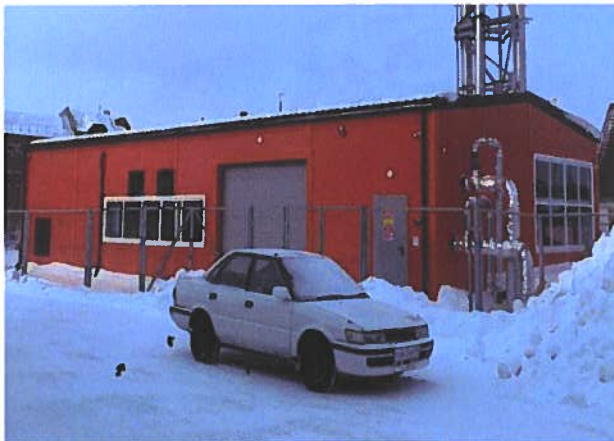
Здание отдельно стоящей котельной
